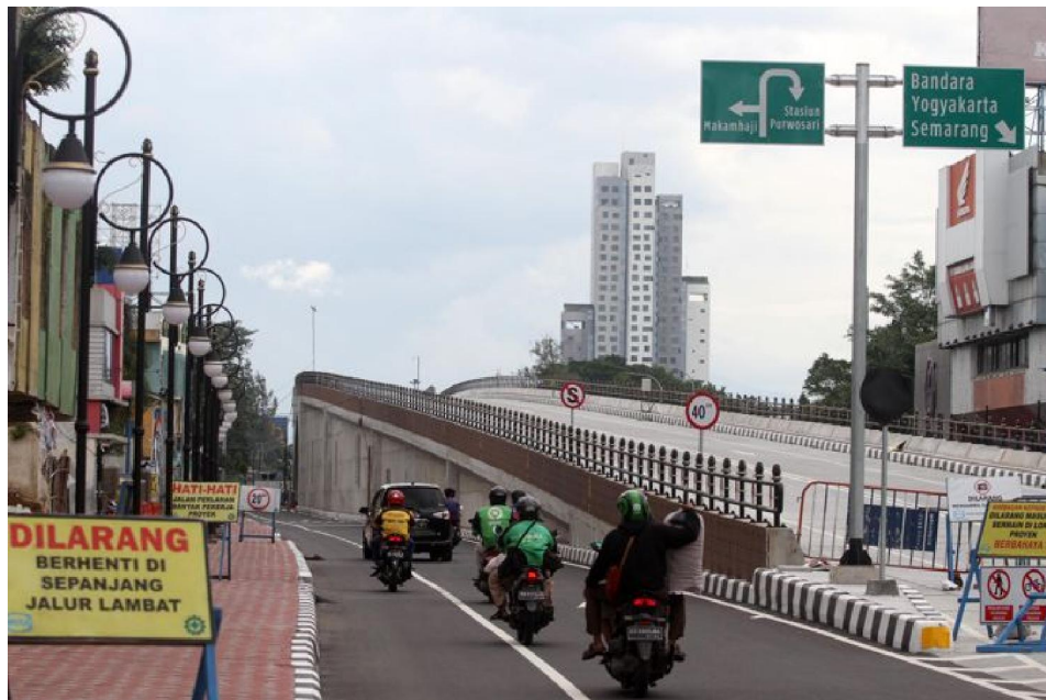
Gambar 4.2. Pembangunan flyover Purwosari
