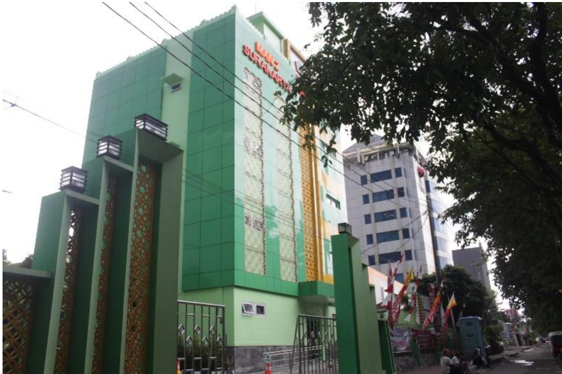
Gambar 3. 16. Gedung MAN 2 Surakarta Sumber: Dok. Konsultan (2022)
