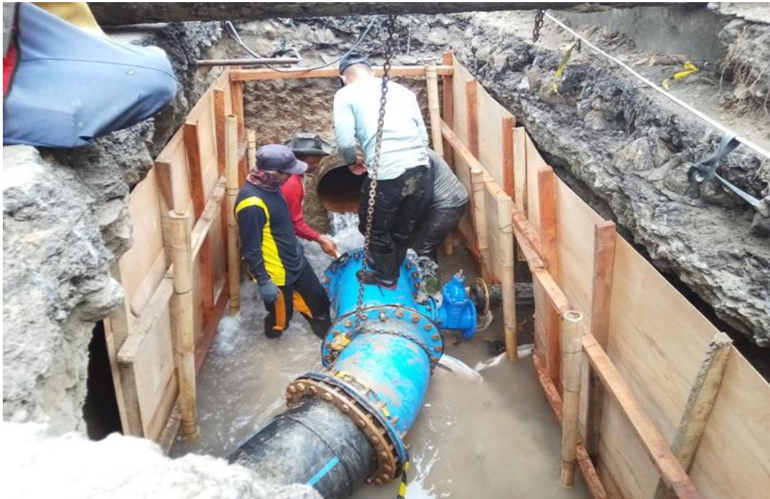
Gambar 3. 19. Pemindahan Pipa Transmisi Jl. Slamet Riyadi Sumber: Timlo.net (2019)
