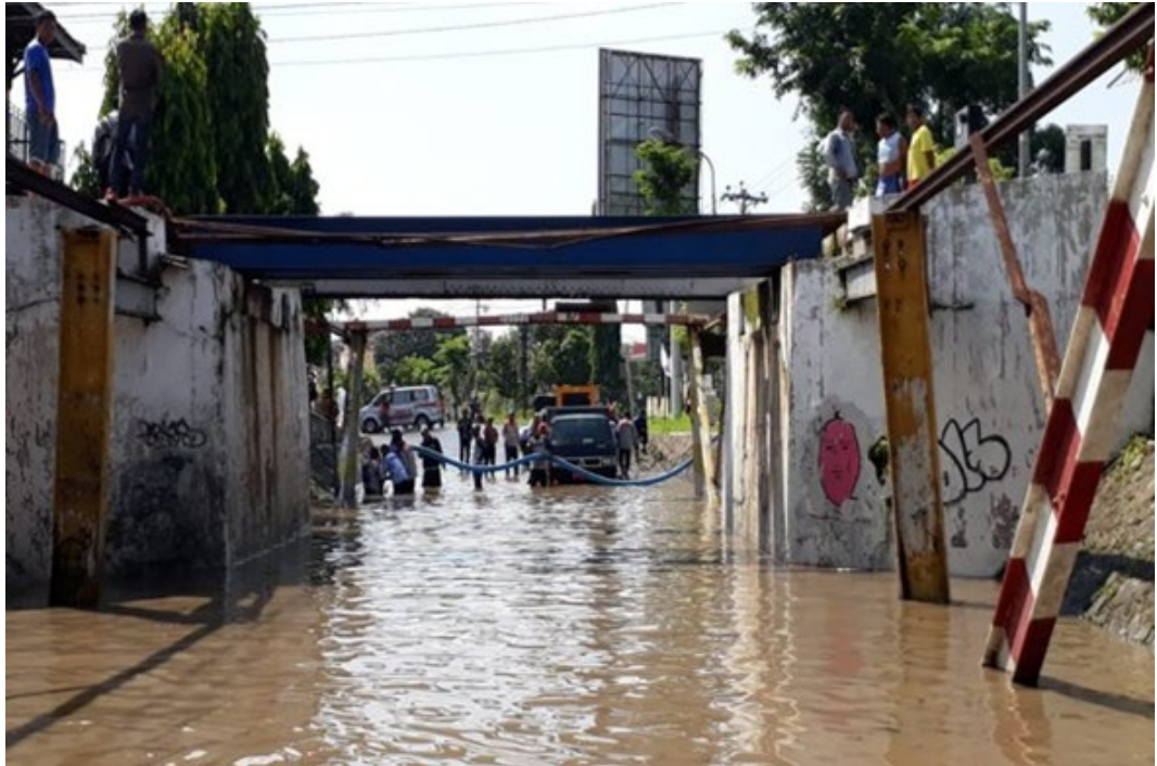
Gambar 5. 8 Genangan di Viaduk Gilingan
