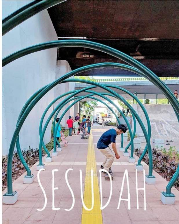
Gambar Fly over Slipi Setelah diperbaiki
